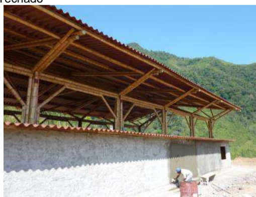
82. Tarrajeo con cemento de paredes exteriores
