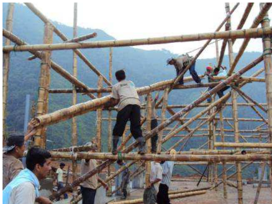
52. Capacitación en armado del casco estructural
