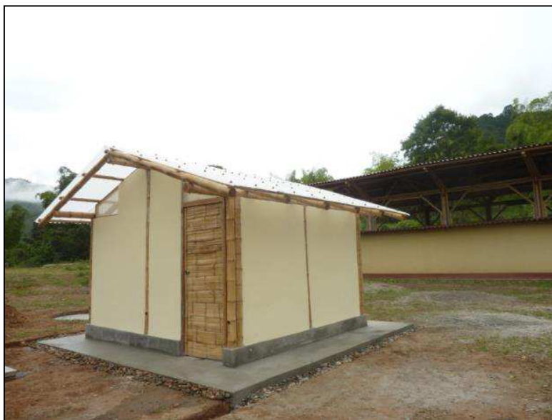
86: Servicios higiénicos del MINCABAMBÚ
