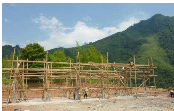
79. Armado de columnas y vigas
