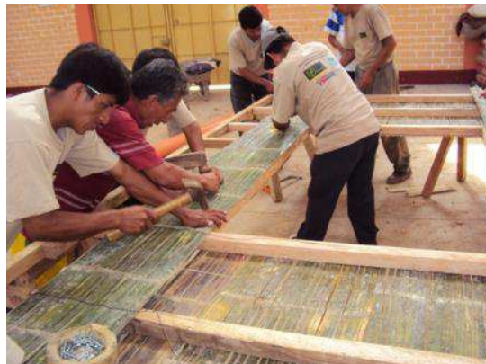
51. Capacitación en armado de paneles
