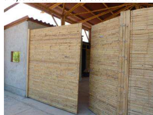
84. Instalación de puertas y ventanas de bambú
